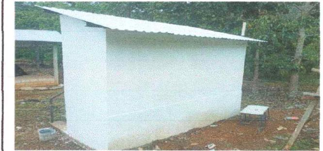
Foto 4: Se evidencia la aplicación de la monocapa en las paredes del baño.
